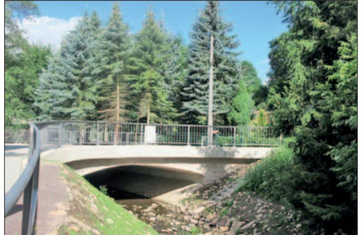
Die Brücke am Abzweig zum Kniependurchbruch hat den größten Durchlass für den Marienbach, da sie in Fließrichtung die am weitesten untenliegende Brücke ist und somit Wasser aus dem größten Einzugsgebiet hier hindurch fließt.
