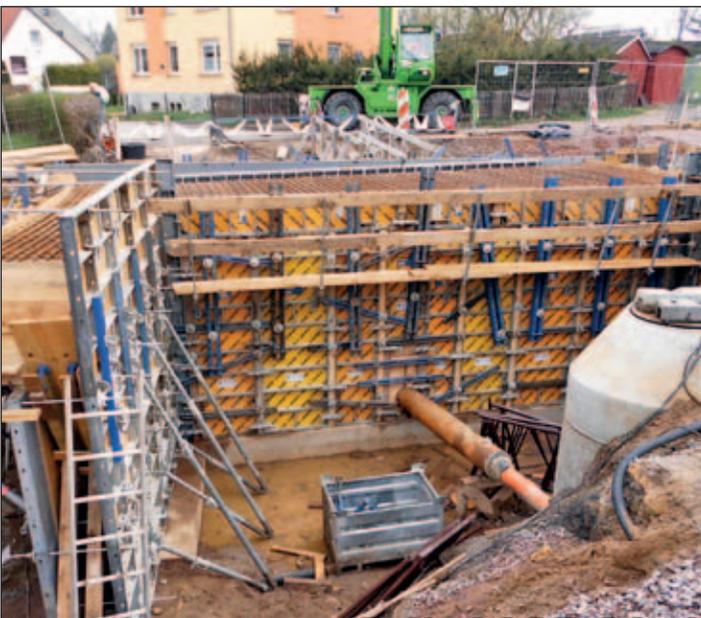
Am 5. April 2017 waren die Schalungsarbeiten soweit vorbereitet, dass der Betonguss beginnen konnte. Eine besondere Herausforderung war die Aufrechterhaltung der Funktionsfähigkeit der zentralen Abwasserentsorgung von Marbach, die direkt unter den neuen Bauwerken hindurchleitet.
