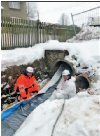
Im Straßenkörper der Bundesstraße B169 wurden sowohl die Grundablass- als auch die Überlaufleitung erneuert. Dabei kam Spezialtechnik zum Einsatz. Mittels eines Inliner-Verfahrens wurde der große Überlaufkanal im Innenwandverfahren saniert, so dass er für die nächsten Jahrzehnte wieder funktionstüchtig sein wird. Unsere Aufnahme vom Januar 2017 zeigt Mitarbeiter des Spezialunternehmens beim Einziehen des Kunststoffes.
