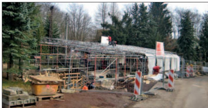
Am 16. Februar 2016 wurde die Brücke am Kniependurchbruch mit einem Zelt eingehaust, so dass trotz zu niedriger Außentemperaturen weiter an dem Bauwerk gearbeitet werden konnte.
