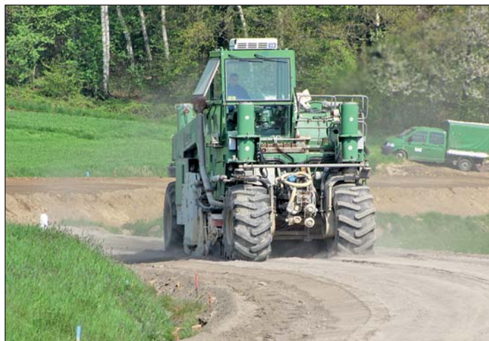
Am 3. Mai dieses Jahres erfolgte mit einer Durchmischung des Straßenunterbaues mit Kalk- und Zementanteilen die Stabilisierung der verbreiterten außerörtlichen Fahrbahn.
