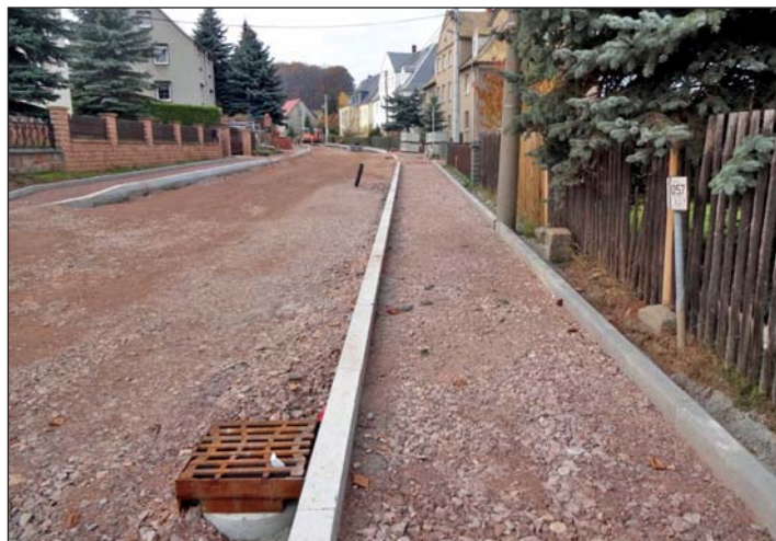
Im Herbst 2015 und im Frühjahr 2016 wurden Borde und Palisaden für die Gehwege und in den Randbereichen gesetzt.
