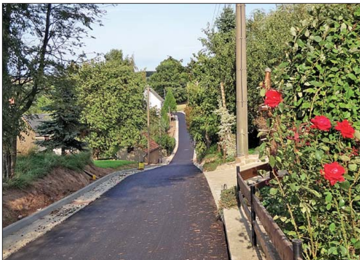
Ende September letzten Jahres wurde die Asphaltdecke auf der 525 Meter langen Baustrecke komplett fertiggestellt.
