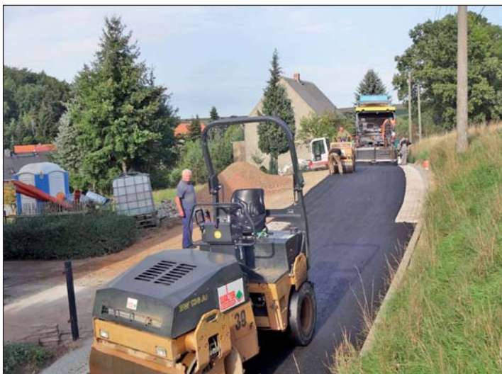
Nach mehrmonatiger Bauzeit wird hier am 17. September 2015 die bituminöse Tragschicht eingebracht.
