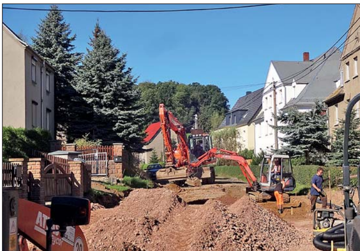
Im Herbst 2015 liefen die Straßenbauarbeiten bereits auf Hochtouren, nachdem in der ersten Jahreshälfte bereits Schmutzwasser- und Straßenoberflächenwasserabführungsleitungen verlegt werden konnten. Dieses Foto entstand am 17. September und zeigt, wie intensiv gearbeitet wurde.
