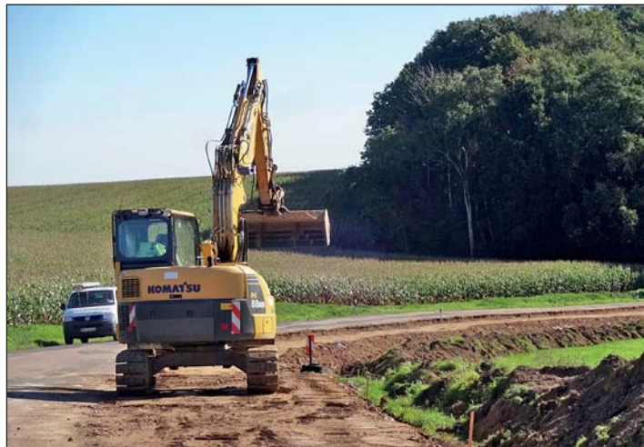
Im außerörtlichen Bereich wurde die Straße deutlich verbreitert. Hier ist der Mutterboden bereits zur Sicherung beiseitegelegt und der bisher unbefestigte Randbereich aufgeschottert.
