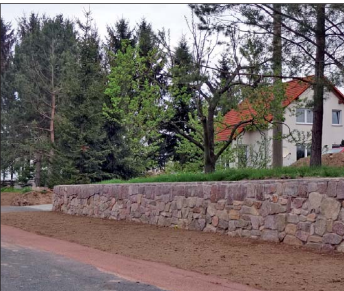
Diese Natursteinmauer an der Grenze des Gasthofgrundstückes wurde neu aufgebaut und stellt nun einen Blickfang am ehemaligen Etzdorfer Gasthof dar.
