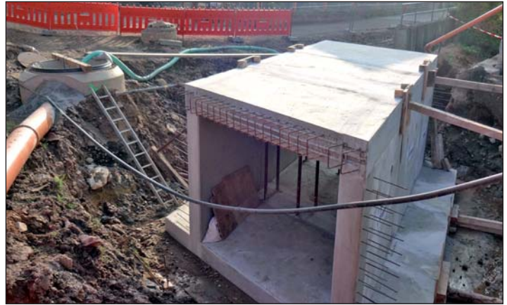
Die Brücke über den Steinbach wurde in mehreren Betonteilen geliefert und ist hier bereits eingesetzt.
