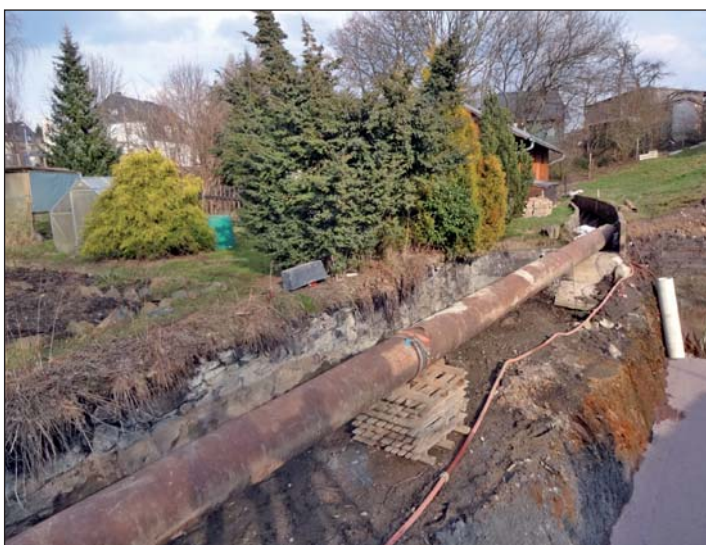
Das Wasser des Schmalbaches musste während der Baumaßnahme durch diese Rohrleitung geführt werden, damit die direkt am Gewässer auszuführenden Arbeiten erledigt werden konnten.
