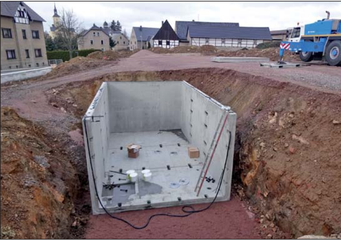
Am ehemaligen Gasthof wird die neue Löschwasserzisterne eingebaut. Sie fasst 96 Kubikmeter und wurde mit Trinkwasser befüllt.
