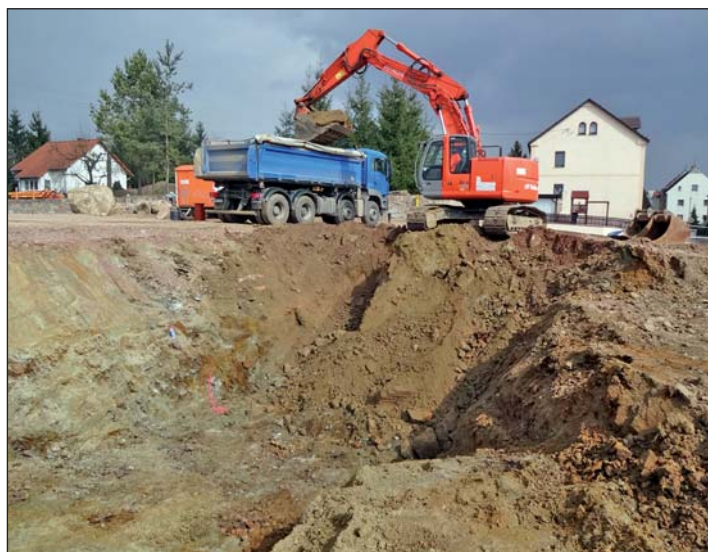
Der Baubetrieb LFT Ostrau führt hier Erdarbeiten zur Vorbereitung des Einbaus der neuen Löschwasserzisterne aus.
