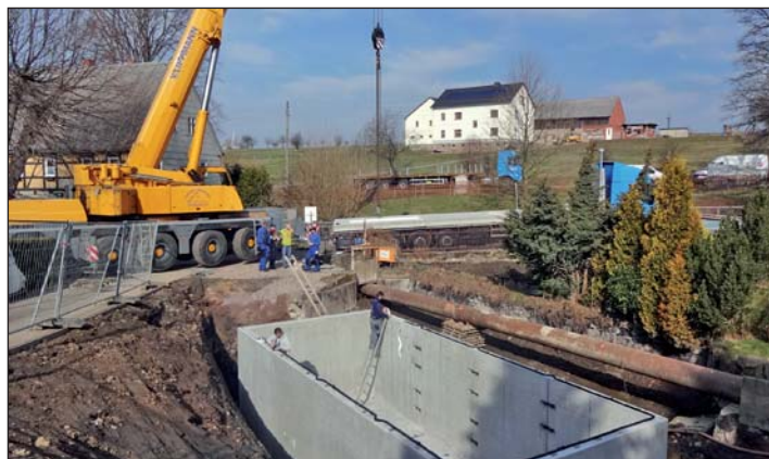
Mit einem 40-Tonnen-Kran wurde die neue Löschwasserzisterne gesetzt.
