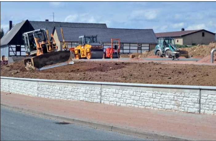
Die neue Stützmauer am Fußweg ist fertiggestellt. Am Gasthofgelände entstand ein Parkplatz für zwölf Pkw, der vor allem der anliegenden Allgemeinanzpraxis von Frau Neuber dienlich sein soll. Hier werden mit schwerer Technik letzte Erdarbeiten ausgeführt.
