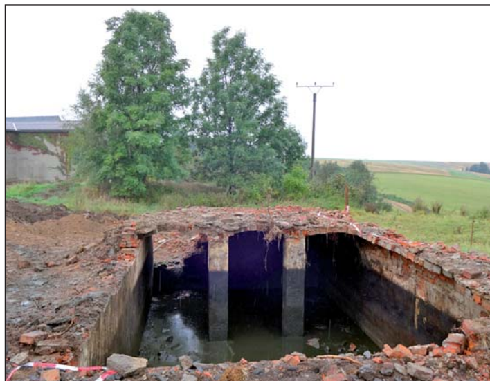
Im Untergrund der Gebäude am ehemaligen Etdorfer Gasthof fand man eine Vielzahl von Bauschuttverfüllungen und Hohlräumen mit unterschiedlichen Nutzungen. Unter anderem wurde diese Güllegrube „entdeckt“ und musste fachgerecht entsorgt werden.
