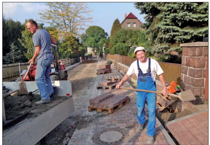
Mitarbeiter der Firma Walter Straßenbau aus Etzdorf arbeiten am Fußweg und den angrenzenden Nebenanlagen an der Straße Zur Höhe.
