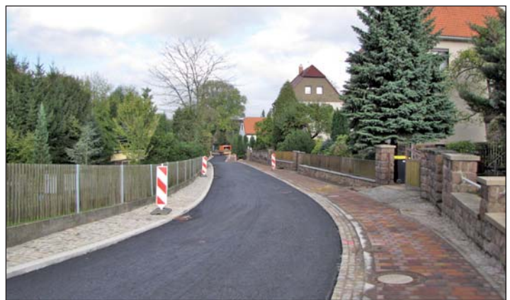
Neben der Beseitigung der Schäden am Straßen- und Brückenkörper wurde auch die defekte Kanalisation in verbesserter Dimensionierung neu hergestellt. Der überfahrbare Fußweg zeigt in seiner Gestaltung deutlich den Vorrang für Fußgänger an, kann gleichzeitig aber auch im Bedarfsfall als Fahrbahn mit genutzt werden. Wir weisen in diesem Zusammenhang darauf hin, dass das Parken auf Fußwegen nicht gestattet ist.
