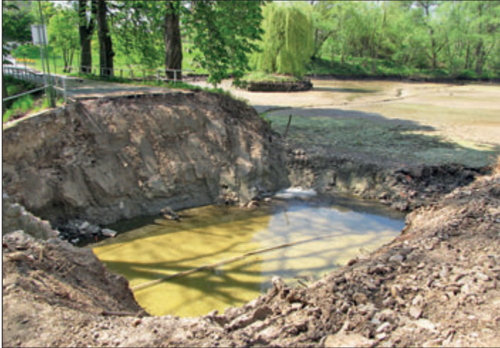
Am 10. Mai 2016 ist die alte Brücke zwischen den Arnsdorfer Teichen bereits abgerissen.
