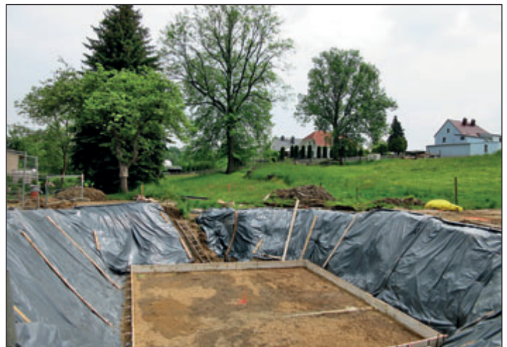
Eine weitere sanierungsbedürftige Brücke führte über den Dorfbach am Abzweig der Straße „Am Dorfbach“ zur Berbersdorfer Straße. Nachdem Ende April 2016 das alte Bauwerk abgerissen wurde, zeigt das am 27. Mai vergangenen Jahres entstandene Bild die für die Fundamentarbeiten zur Aufnahme des neuen Bauwerkes vorbereitete Baugrube.
