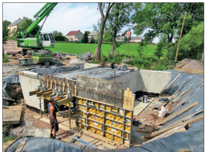
Am 11. Juli 2016 liefen die Schalungsarbeiten zum Neubau der Brücke auf Hochtouren.
