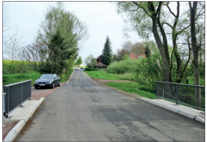
Seit Herbst 2016 ist die neue Brücke fertiggestellt und wird für viele Jahrzehnte wieder eine sichere Verbindung über den Dorfbach entlang der Berbersdorfer Straße in Arnsdorf bieten.
