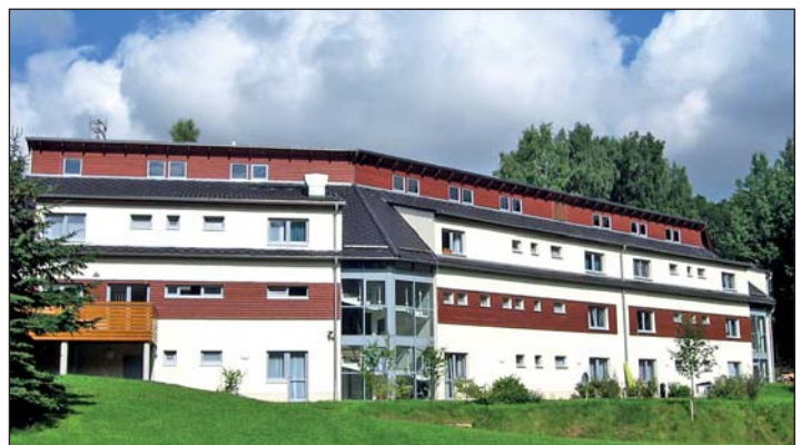
Der Wohnheimneubau im Jahre 2010
