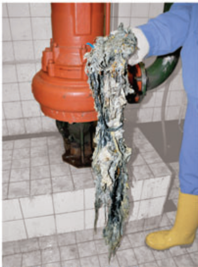
Sieht über aus und ist es auch: verfilzte Feuchttücher. Regelmäßig legen sie Abwasser Systeme lahm.
