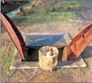
Auffangeimer mit gesammelten Feuchttüchern im Verbandsgebiet der OFM.
