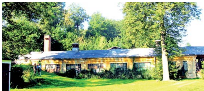
Das Betriebsgebäude im Jahre 2011
