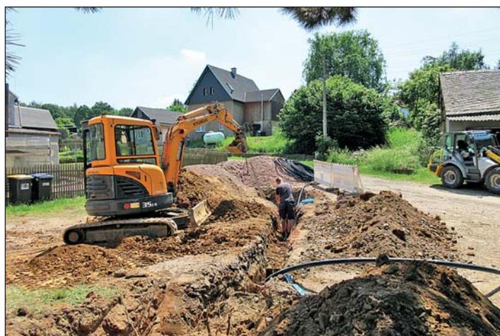
Ab Juni 2016 begannen die Arbeiten zum grundhaften Ausbau. Hier werden im Auftrag des kommunalen Trinkwasserver- und Abwasserentsorgungszweckverbandes „Mittleres Erzgebirgsvorland“ am 8. Juni 2016 zunächst neue Trinkwasserversorgungsleitungen verlegt.
