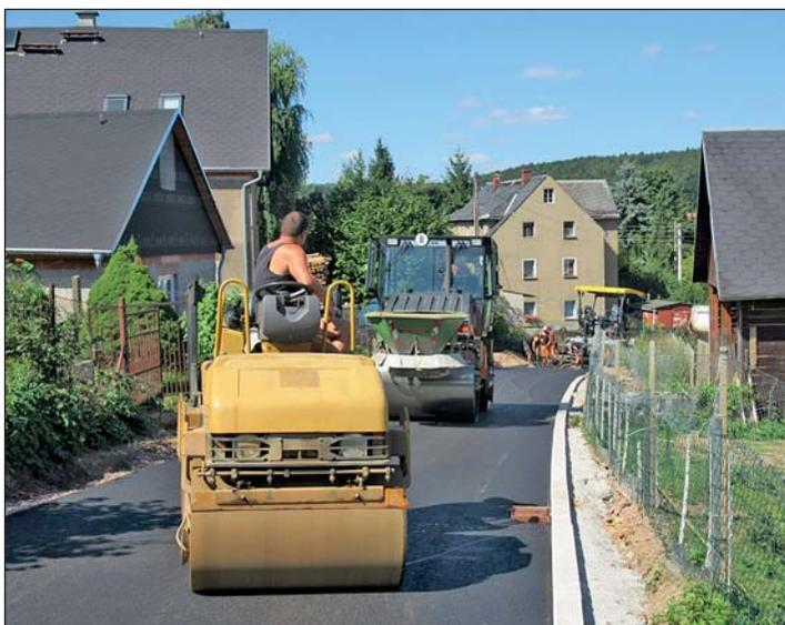
Nach Einbau der Straßenentwässerungsleitungen und einer dazu gehörigen einseitigen Bordanlage zur Führung des Oberflächenwassers wurde am 24. August 2016 die bituminöse Trag-schicht eingebaut.
