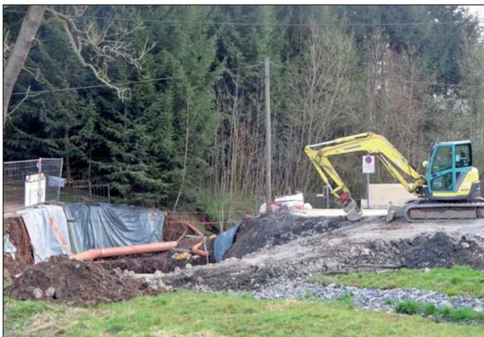
Anfang April 2016 ist die defekte Brücke der Badstraße über den Dorfbach abgerissen, dessen Wasser zur Ausführung der Fundamentarbeiten zeitweise durch eine Verrohrung geführt wurde.
