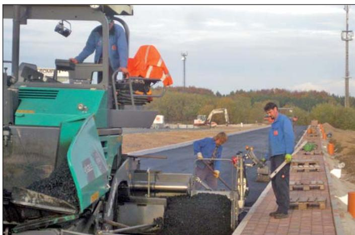
Die Arbeiten zur Gewerbegebieterschließung in Berbersdorf konnten in diesem Jahr fortgeführt werden. Hier arbeiten Ende Oktober 2013 Mitarbeiter der Firma Gunter Hüttner aus Chemnitz am Bitumenauftrag an einer Erschließungsstraße.
