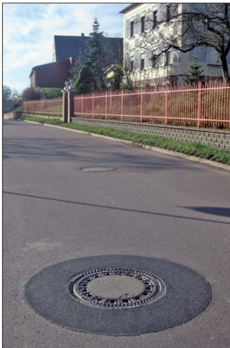
*Auch Reparaturarbeiten sind notwendig. Hier wurden an der Ortsdurchfahrt in Etzdorf abgesenkte Gullideckel mit einer neuen Methode reguliert.*
