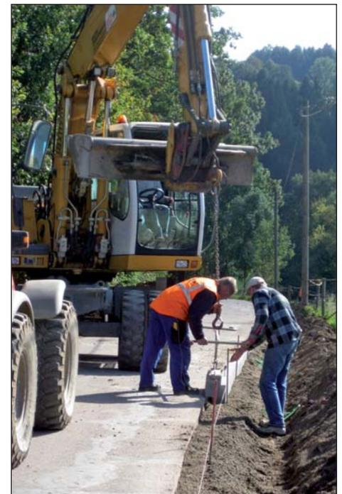
*Auch in diesem Jahr wurde wieder an der Verbesserung der Oberflächenwasserabfuhr an den Zufahrten nach Gößberg gearbeitet. Hier setzen Mitarbeiter der Firma Walter Straßenbau KG aus Etzdorf Borde an der Verbindungsstraße von Gößberg zum Lichtenstein. Die Aufnahme entstand im September dieses Jahres.*
