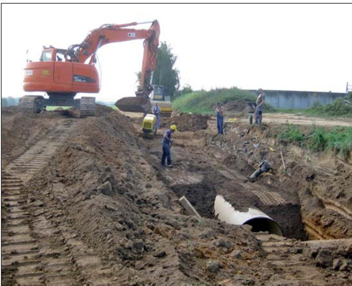
Diese Aufnahme vom 5. September 2013 zeigt Mitarbeiter der Firmen Bickhardt Bau Thüringen und Walter Straßenbau Striegistal bei der Verlegung von Abflussleitungen aus dem neuen Regenrückhaltebecken.
