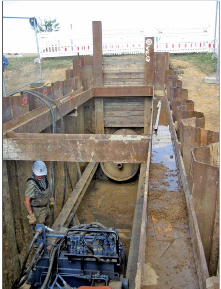
Mit Spezialtechnik werden 1,20 Meter starke Rohrleitungen tief unter dem Freiburger Steig durchgepresst, die zukünftig der Entwässerung von 30 Hektar Gewerbefläche dienen werden.
