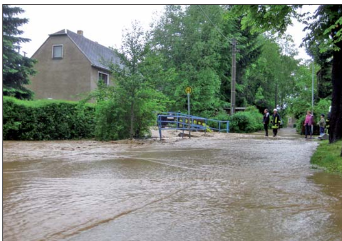
Diese Aufnahme entstand am Nachmittag des 31. Mai 2013 und zeigt die Straße am Dorfbach in Arnsdorf, deren völlige Überflutung zum Wegrutschen von Stützmauern und dem Unterspülen von Bitumenflächen führte.
