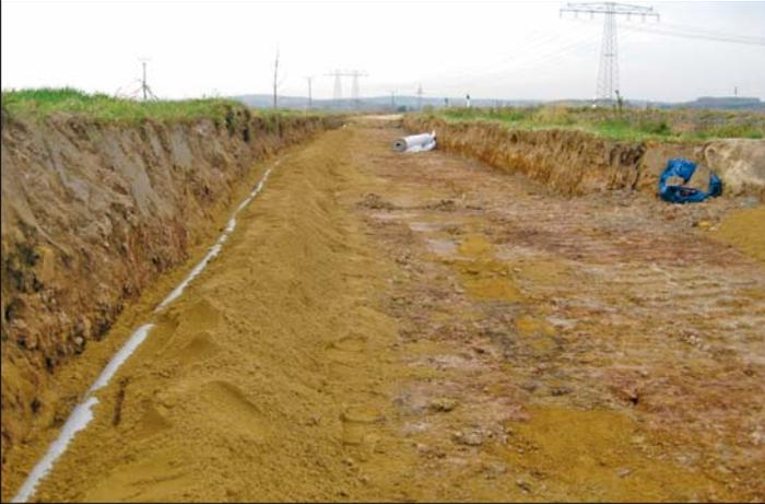
Unter der neuen Wegeverbindung wurde neben einer Längsdrainage zum angrenzenden Feld auch eine Mittelspannungsleitung mitverlegt, die ab 2012 die jetzt in Oberleitung vorhandene Trasse zwischen Mobendorf und Pappendorf ersetzen wird. Unsere Aufnahme dokumentiert die eingesandeten Kabel und Rohre.
