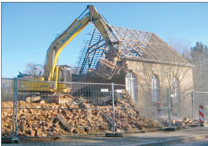
Auch der Saal des ehemaligen Gasthofes wird ein Opfer des Abrissbaggers.
