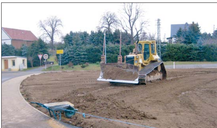
Geschafft! Am 13. Dezember 2011 erfolgte die abschließende Geländeregulierung. Auf dem Grundstück entstand ein kleiner Parkplatz für die Besucher des angrenzenden öffentlichen Spielplatzes.
