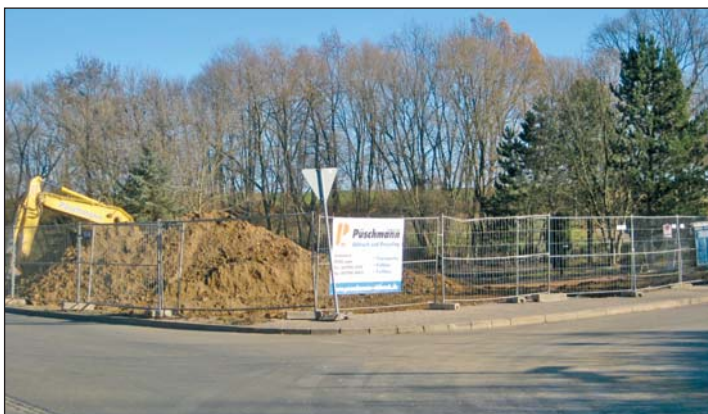
Der Gasthof war teilweise unterkellert. Da der Abriss bis auf die Grundmauern des Kellerbereiches erfolgte, konnte man am 29. November dieses Jahres den Bagger des Abrissunternehmens kaum noch über der umgebenden Oberfläche sehen.
