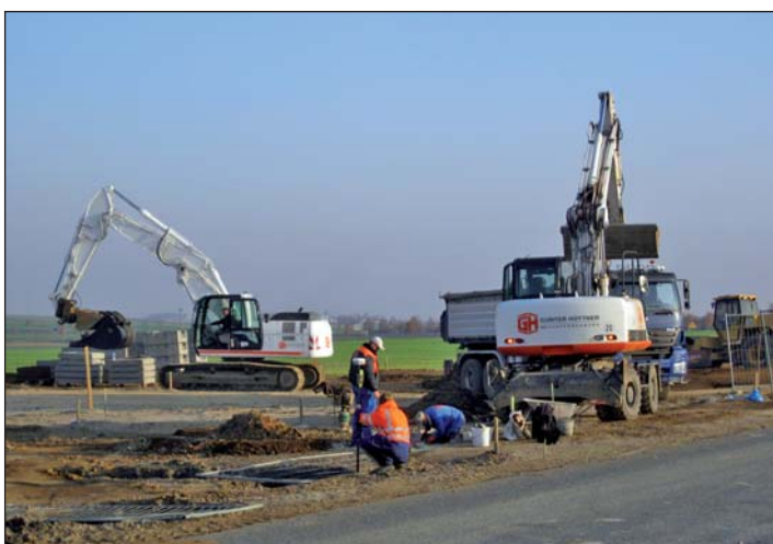
Ende dieses Jahres wurde mit Hochdruck an der Fertigstellung der neuen Kreuzung der Staatsstraße S 34 mit den Gewerbegebieterschließungsstraßen gearbeitet. Unsere Aufnahme vom 7. November 2011 zeigt schwere Technik bei Arbeiten am Unterbau des Kreuzungsbereiches.
