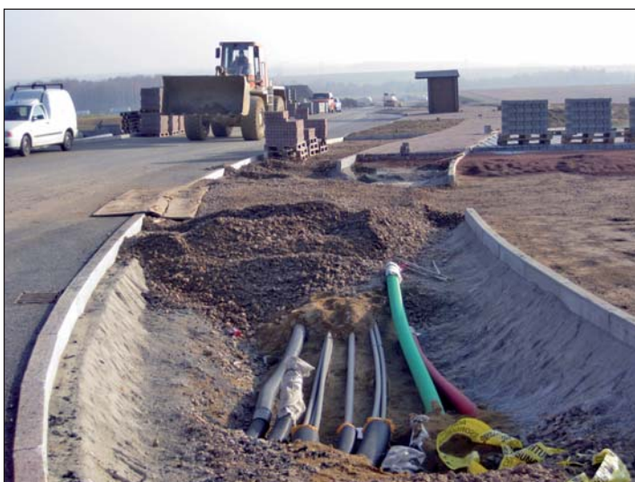
Unsere Aufnahme zeigt einen Teil der notwendigen Leitungs- und Rohrverlegungen im Bereich der neuen Gewerbegebieterschließungsstraße.
