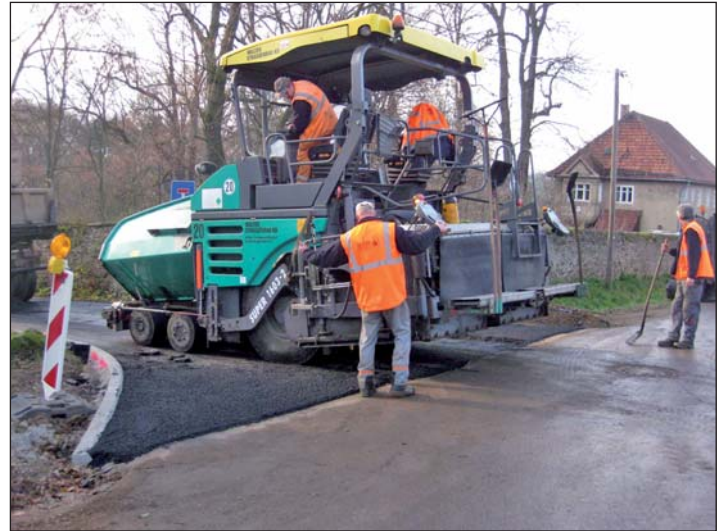
Bereits Anfang Dezember dieses Jahres konnten die Bitumenarbeiten an der Zufahrt zum Gersdorfer Schloss zur Ausführung kommen.
