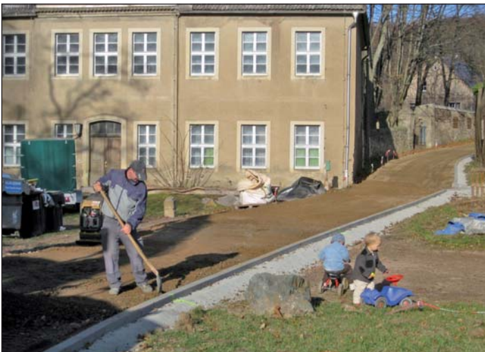
Mitarbeiter der Firma Walter Straßenbau KG aus Etzdorf arbeiten am 28. November 2011 am Unterbau der kommunalen Straße am Gersdorfer Schloss.
