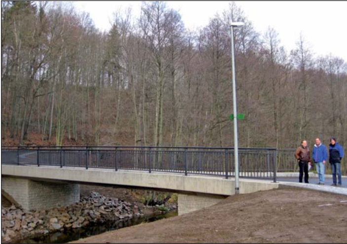
Dieses Bild entstand am Tag der Endabnahme, dem 6. Dezember 2011, und zeigt die fertig gestellte Brücke.
