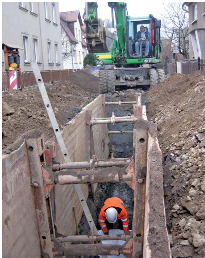
Unsere Aufnahme vom 1. Dezember 2011 zeigt wie tief die Mitarbeiter der hier arbeitenden Bauunternehmen für die Verlegung von Rohrleitungen in den Straßenbereich eingedrungen sind.
