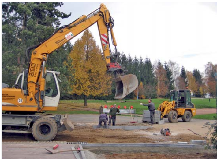
Dieses Foto entstand am 4. November dieses Jahres und zeigt Mitarbeiter der Firma Walter Straßenbau KG aus Etzdorf beim Verlegen von Bordsteinen am neuen Parkplatz, oberhalb des Marbacher Friedhofs- und Schulgeländes.
