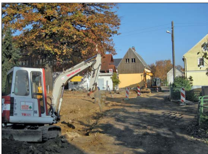
Am 8. November 2011 entstand diese Aufnahme, welche die Bauarbeiten am Einmündungsbereich der Haupt- zur Lorenzstraße in Marbach dokumentiert.
