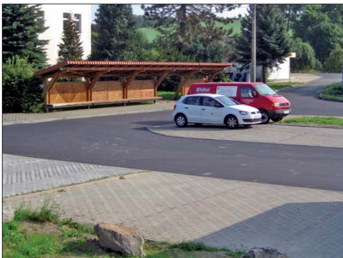
Die Buswendeschleife an der ehemaligen Schule musste mit dem Bau der Hochwasserschutzmauer in ihrer Lage verändert werden. Da dadurch an dieser Stelle PKW-Stellflächen zurückgebaut werden mussten, wurden diese neben der neu asphaltierten Buswendeschleife in gleicher Anzahl neu angelegt.
