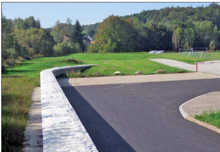
Die mit Natursteinen verblendete Schutzmauer fügt sich gut in das Ortsbild ein. Sie geht nahtlos in den erdgeschütteten Damm über.
