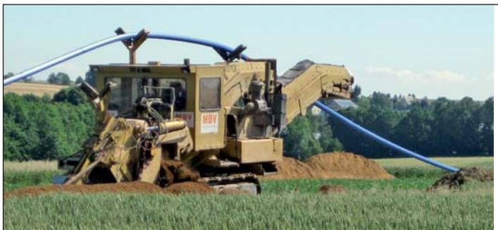
Mit schwerer Technik werden die Trinkwasserleitungsleitungen innerhalb eines Arbeitsganges frostsicher verlegt.
