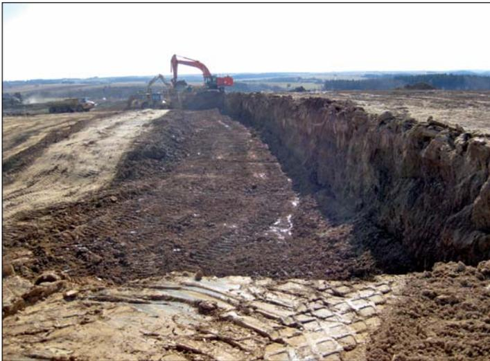
Mit 25 Hektar Größe ist die Erschließung des Gewerbegebietes am Berbersdorfer Autobahnanschluss derzeit flächenmäßig Mittelsachsens größte Baustelle. Mit schwerer Technik werden täglich rund 20.000 Tonnen Erde bewegt und so Schritt für Schritt das neue Geländeprofil hergestellt.
