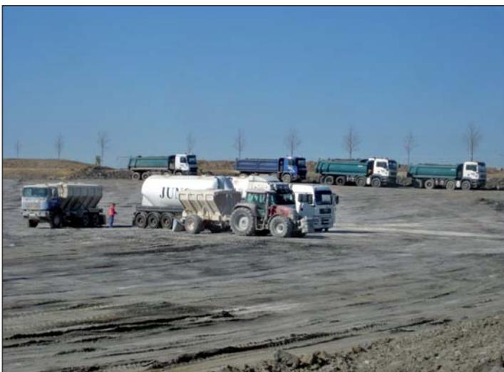
Durch schichtweise Kalkstabilisierung wird die Tragfähigkeit des Bodens verbessert. Trotz vorher durchgeführter Untersuchungen des Baugrundes kommt es hier zu erhöhtem Aufwand, da an einigen Stellen Granit im Untergrund vorgefunden wurde.
