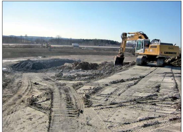
Mitarbeiter der Firma Walter Straßenbau KG Etzdorf als Nachauftragnehmer der Tesch Straßenbau GmbH & Co. KG Schkeuditz bei Profilierungsarbeiten an der Böschung eines Regenrückhaltebeckens an der Autobahn.
