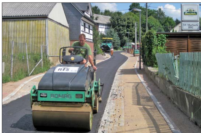
Unsere Aufnahme vom 10. August 2010 zeigt Mitarbeiter der Firma ATS Chemnitz beim Aufbringen der bituminösen Tragschicht an der Rosentalstraße in Marbach.
