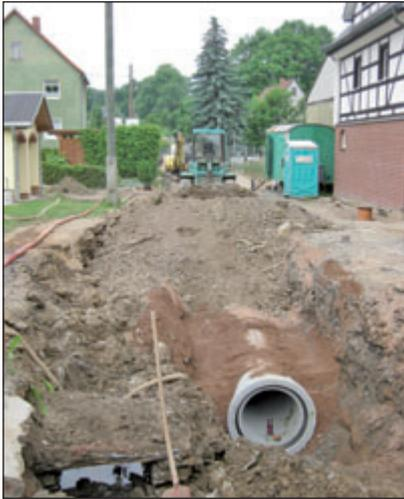
Die Bauarbeiten an der Rosentalstraße in Marbach liegen im Zeitplan. Zunächst werden hier die Leitungen für die zentrale Abwasserentsorgung in diesem Bereich von Marbach verlegt. Parallel dazu wird eine Neuverrohrung eines Gewässers zweiter Ordnung vorgenommen.
