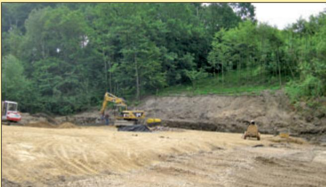
Auf diesem Foto vom 23. Juni 2010 ist erkennbar, dass die Gründungsarbeiten am Hochwasserdamm ihrem Abschluss entgegen gehen und nunmehr mit dem eigentlichen Dammaufbau begonnen werden kann.
