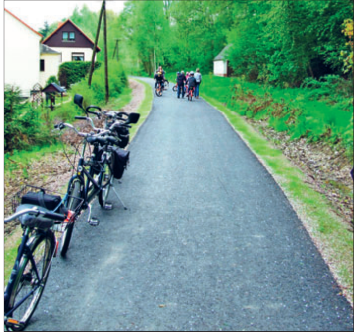
Diese Aufnahme vom neuen Radweg auf Niederstrieigiser Gemar- kung zeigt, wie es zukünftig auch auf der gesamten Radwegestrecke zwischen Hainichen und Roßwein aussehen wird.
