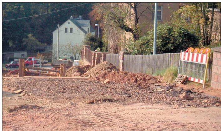
Besonders aufwändig gestalten sich die Arbeiten am so genannten Auberg. Hier finden derzeit umfangreiche Arbeiten zur Um- und Neuverlegung von Kabeln sowie Kanal- und Wasserleitungsarbeiten statt.
