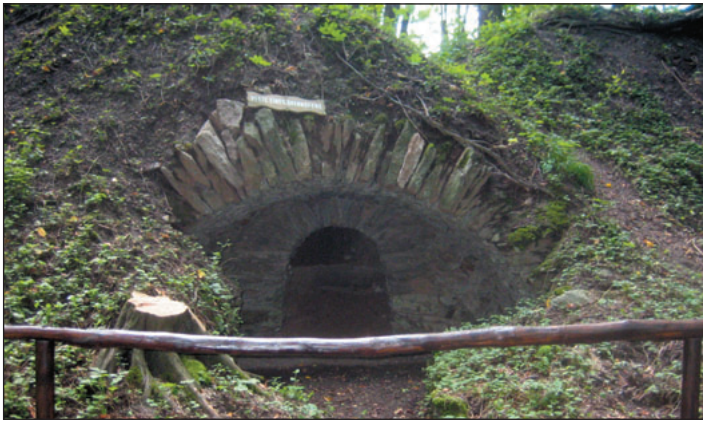
Unsere Aufnahme vom 6. September 2007 zeigt einen Teil der freigelegten Reste eines Kalkbrennofens.
