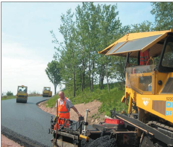
Unsere Aufnahme vom 11. Mai 2007 zeigt das Aufbringen des Bitumenoberbelages durch Mitarbeiter der Firma Chemnitzer Verkehrsbau GmbH. Der von der Gemeinde wiederum geforderte Mastix-Belag sorgt für eine besonders griffige und stabile Oberfläche der neuen Fahrbahn.
