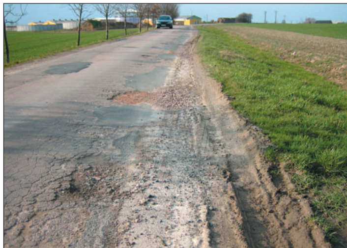
Das Foto vom 7. März dieses Jahres zeigt deutlich die schweren Schäden an der Straße von Berbersdorf zur Anschlussstelle der Bundesautobahn A 4.
